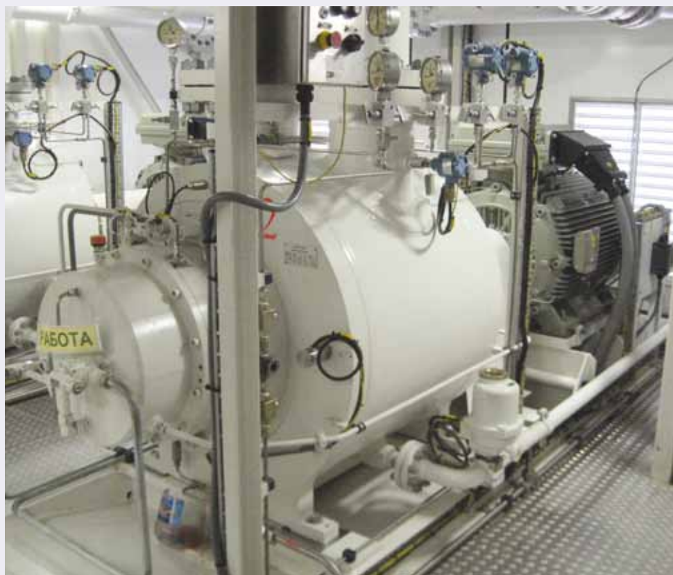
Deze meerfasepomp (made in Holland) verpompt een mix van olie en gas uit een Siberische bron
